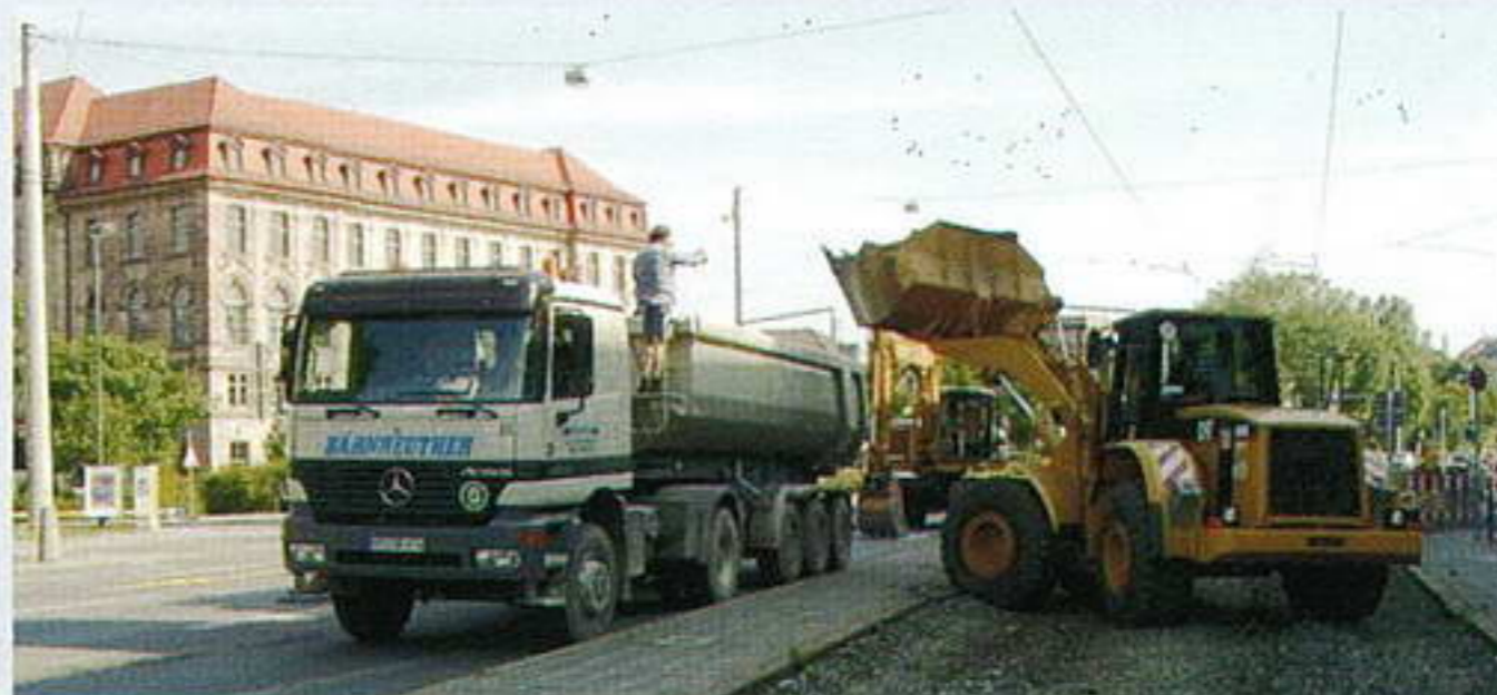
Abtransport von Bahnschwellen in Nürnberg Marienortgraben
