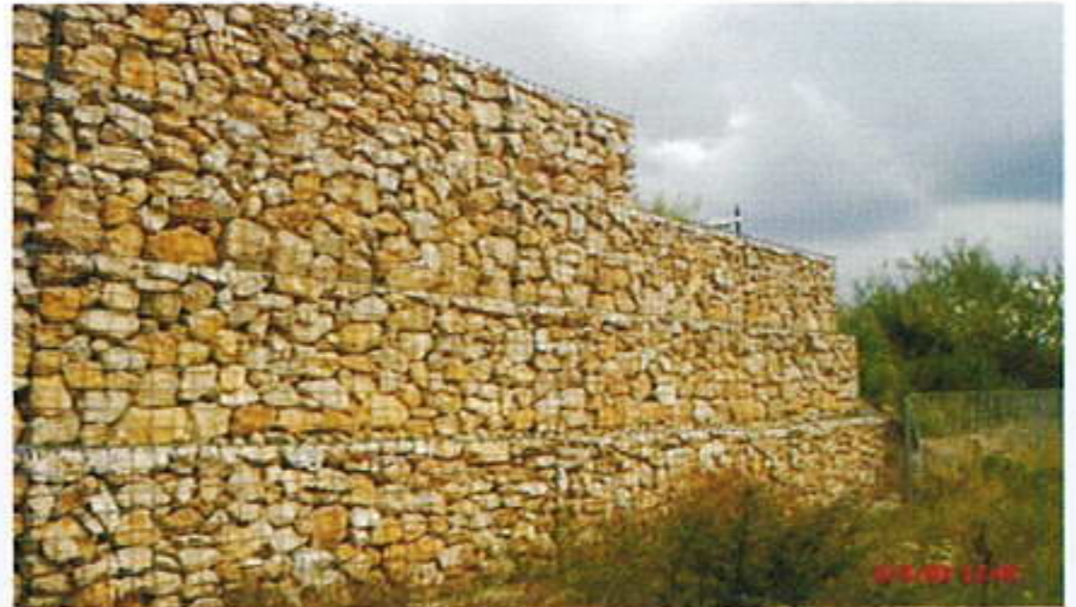
Gabionenwand mit Dolomitwasserbausteinen bei Fürth (Euromed Klinik)
